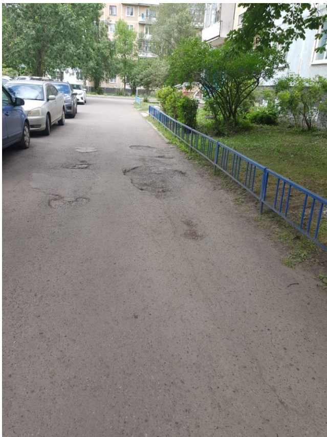
Рис.№ 3. Состояние покрытий проездов.
